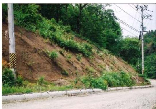
**写真左)** 施工直後（2001年7月）：近隣のコナラ林から採取した表土を植生基材に10%配合して吹き付け。
